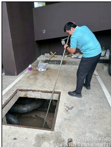
การสูบลูบตะกอนออกจากกระบบบำบัดน้ำเสีย
