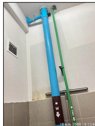
วางระบายน้ำภายในห้องพักมูลฝอยเชื่อมต่อกับระบบบำบัดน้ำเสียของโครงการ
