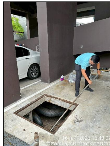
การสูบลูบตะกอนออกจากกระบบบำบัดน้ำเสีย
