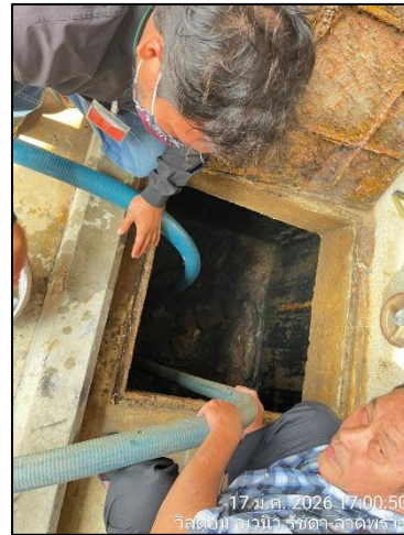
การสูบลูบตะกอนออกจากกระบบบำบัดน้ำเสีย
