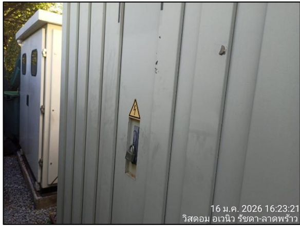
หม้อแปลงที่รับกระแสไฟฟ้าจาก กฟน.
