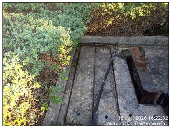
ตะแกรงดักมูลฝอยที่บ่อบำบัดน้ำสุดท้ายก่อนระบายออกนอกโครงการ
