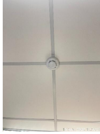
เครื่องตรวจจับควัน และเครื่องตรวจจับความร้อน
