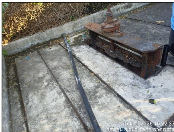
ตะแกรงดักมูลฝอยที่บ่อบำบัดน้ำสุดท้ายก่อนระบายออกนอกโครงการ
