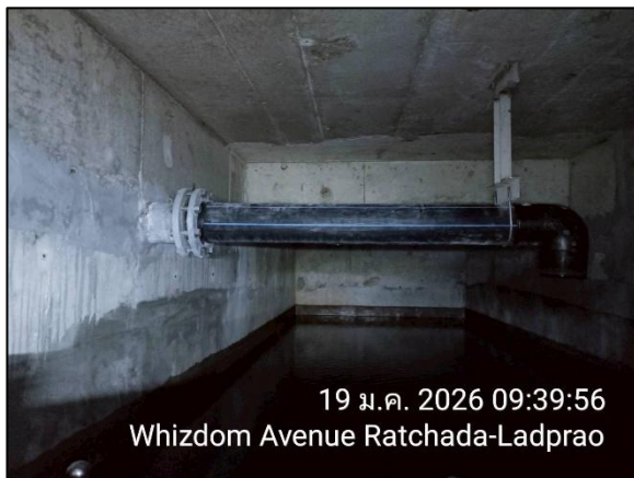
ถังเก็บน้ำสำรองใช้เพื่ออุปโภค-บริโภคชั้นใต้ดิน
