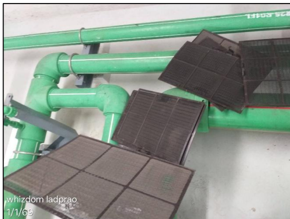
รูปที่ 2.2-14 ล้างแผ่นกรองอากาศของเครื่องปรับอากาศ
