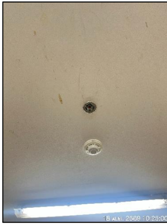
เครื่องตรวจจับควัน และเครื่องตรวจจับความร้อน
