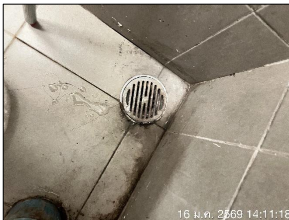
วางระบายน้ำภายในห้องพักมูลฝอยเชื่อมต่อกับระบบบำบัดน้ำเสียของโครงการ
